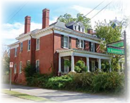
221 S. Sycamore Street
