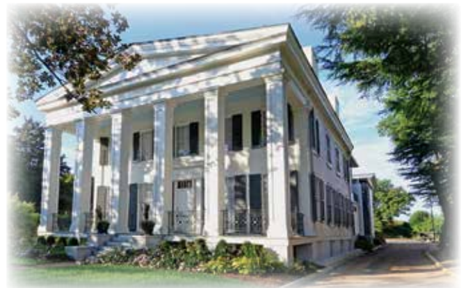
228 S. Sycamore Street
